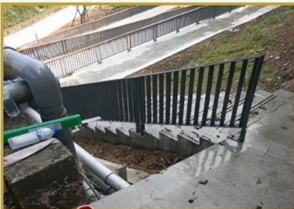
水利處斜坡道工程入口處
