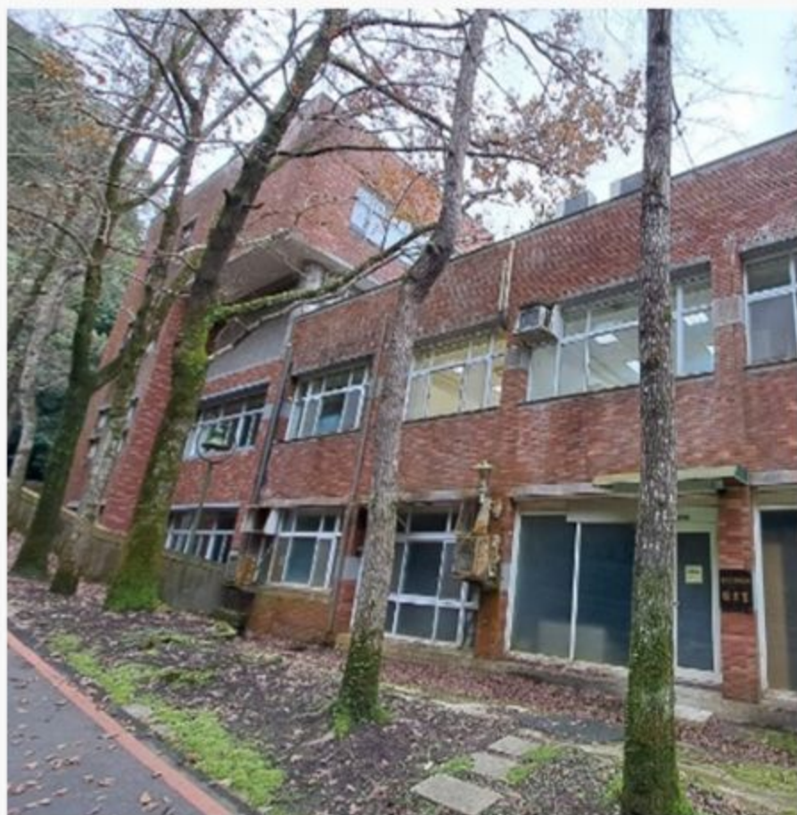
背面外牆清洗前
