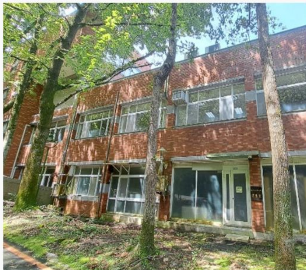
背面外牆清洗後
