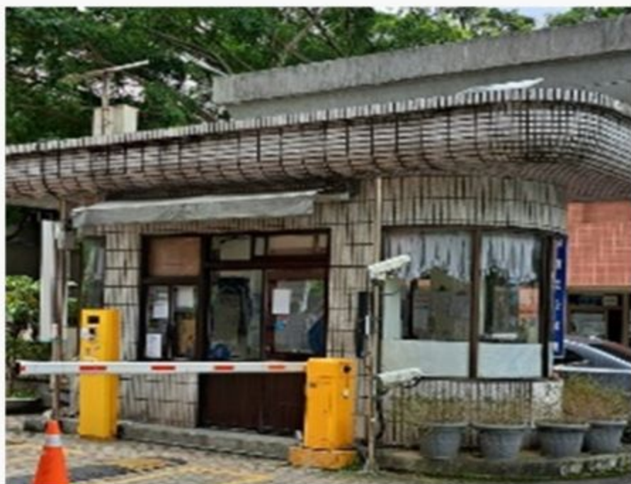
崗亭外牆清洗前
