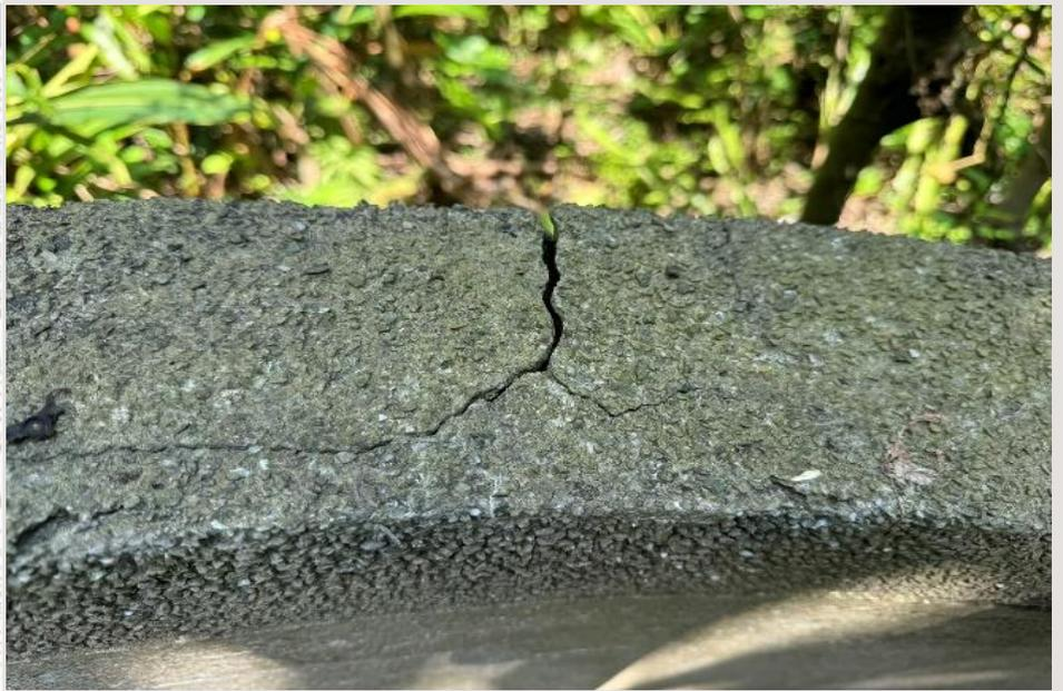
好漢坡邊坡水泥護欄於113年6月監測結果有外移現象，且有落石等風險，為顧及人行安全、邊坡樓梯封閉並進行檢修及評估後續補強工法
