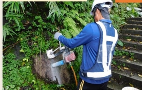
混凝土鑽心試驗
